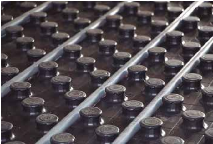
Gráfico 2-34. Detalle de suelo radiante
