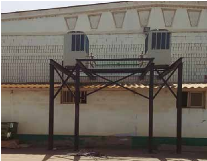
Gráfico 5-29. Caso de éxito once. Unidades exteriores en bancada
